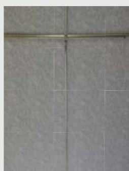
▲ Zusätzliche Dachstangen stabilisieren die Dachfläche.
